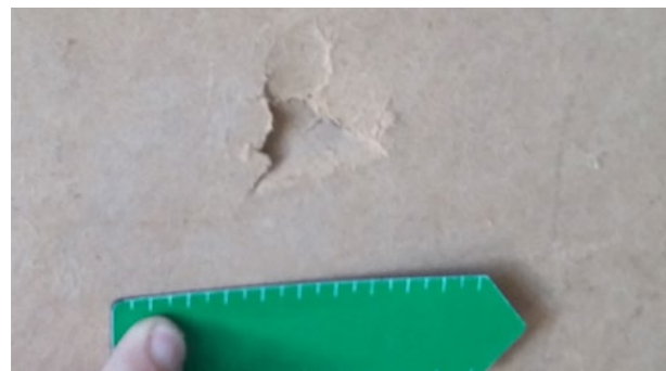
📅 Drvena unutrašnja zaštita: Mali udari
