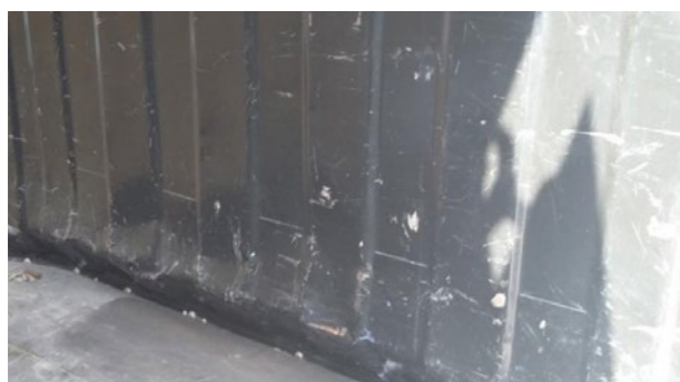
📅 Unutrašnje deformacije: Blaga deformacija bez perforacija ili razreza, vreme popravke \leq 3 h
